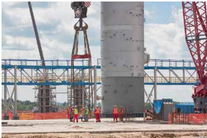
Строительство Амурского ГПЗ
