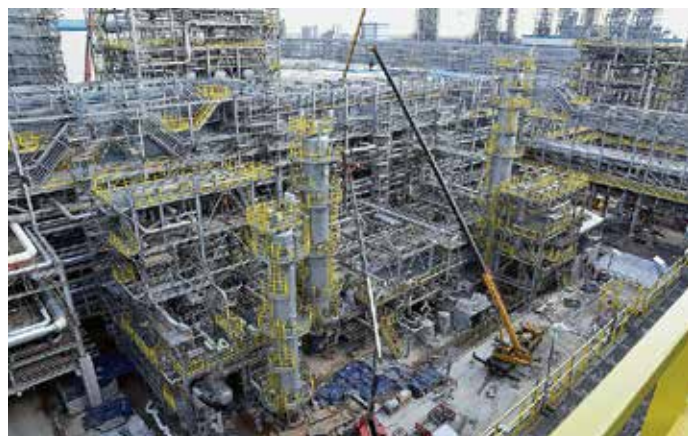
Тобольская площадка «СИБУРа». Строительство «ЗапСибНефтехима», крупнейшего современного нефтехимического комплекса в России
